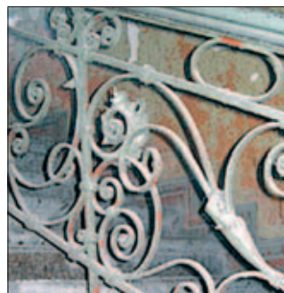
i klatka schodowa - Sienkiewicza 67
